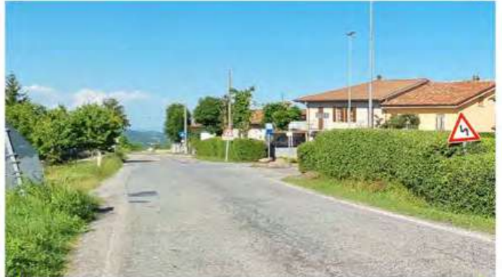
Pre e post intervento
