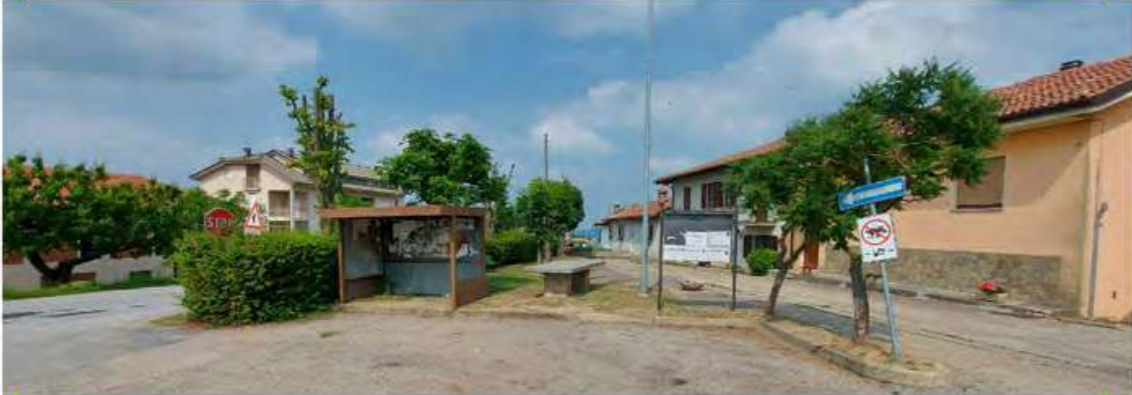
Pre e post intervento
