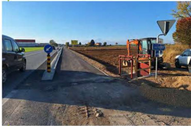
Fase di cantiere
